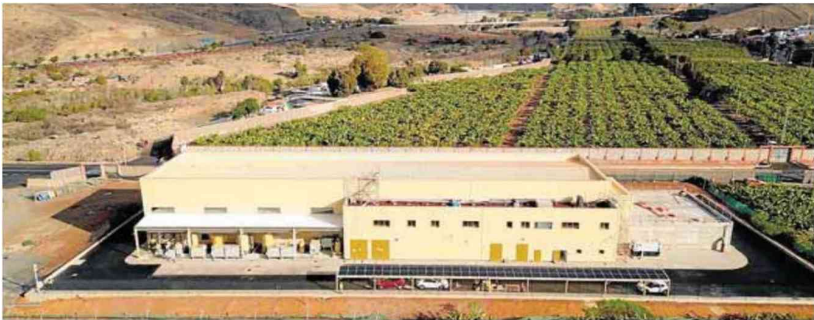
Vista aérea de la desaladora de El Pajar, por donde empezaron las obras del salto hidroeléctrico. REE
