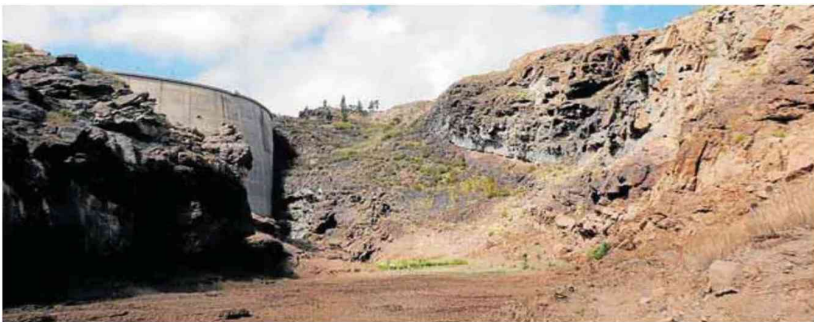
El embalse de Soria, vaso superior del salto hidroeléctrico, totalmente vacío desde el inicio de las obras. REE
