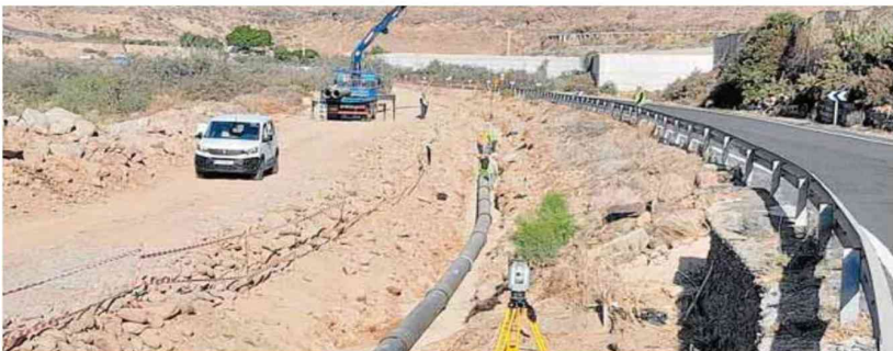
Obras de tendido por el barranco de Arguenguén de la tubería que impulsará el agua a las presas. REE
